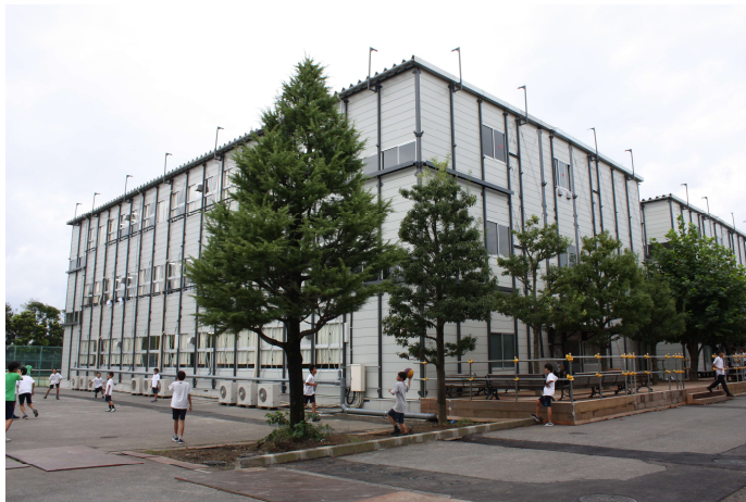
旧バスケットボールコートに建てられた仮設校舎は2学期から使用を開始しています
