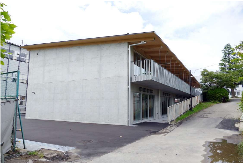
陸上トラック下から見た西棟
