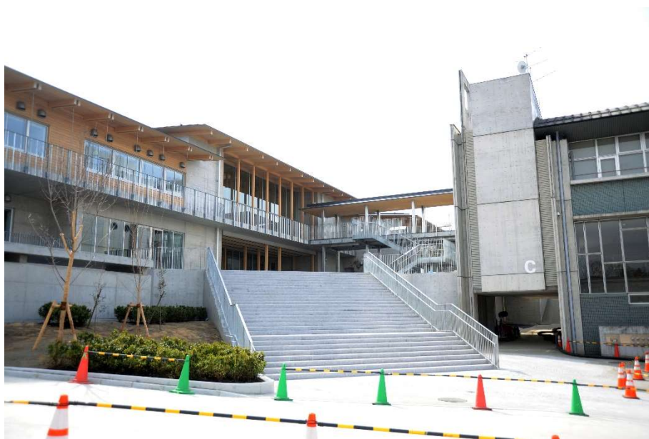
校舎(北棟)へ上がる屋外階段 (右は複合校舎)
