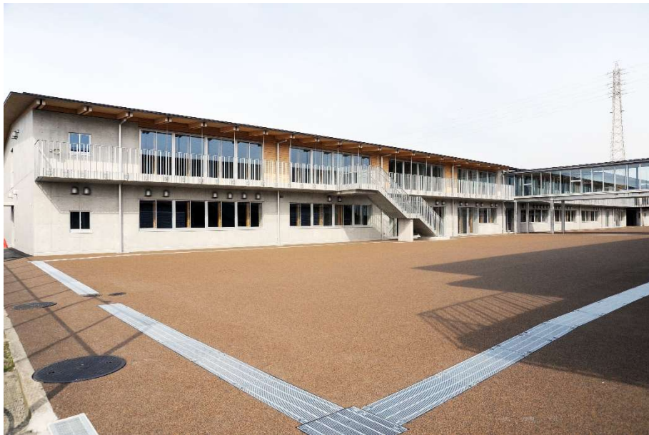
体育館側から北棟
